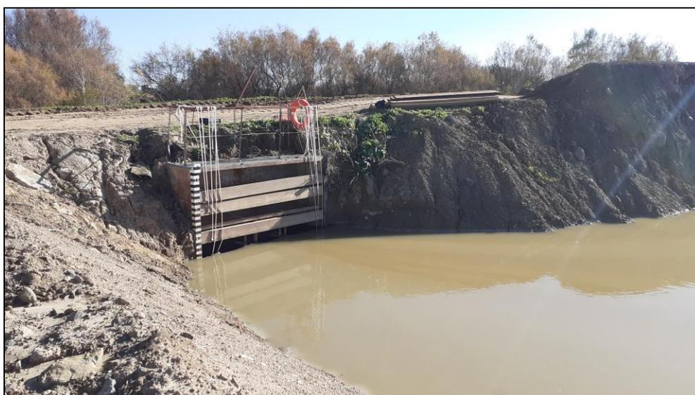
Ilustración 2. Caja de agua del vaciadero de Butano
